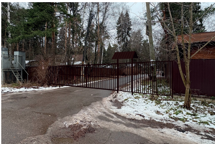
№1 Секционная сварная конструкция из профильных труб
